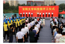
安阳大学科技园开工仪式 李公乐宣布项目开工
