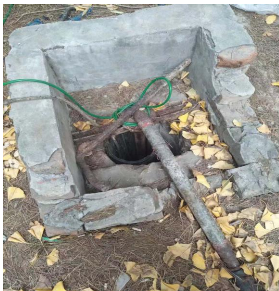
图 5.4-11 抽水试验现场工作照片
